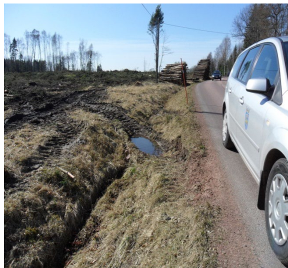
Skador på diken och vägtrummor där den som orsakat skadorna är återställnings-/ersättningsskyldig. I bakgrunden ses två vältor som utsätter trafikanter för fara då de är fel-placerade och den ena lutar in mot vägen och utgör rasrisk.
